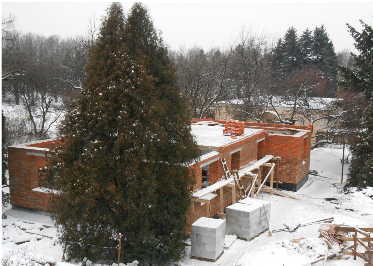
Стройка здания Флоры, 2013 г.
