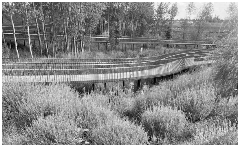
Рис. 3. Дорожно-тропиночная сеть в виде помостов на сваях, «Сад исцеление природой», Сколково, Россия (фото автора)
