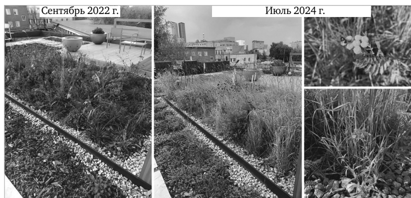
Рис. 3. Мониторинг общего состояния «природной» кровли
